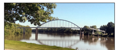
Bridge in Des Arc, Arkansas.
